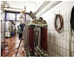
Kontrolle der Filteranlage
